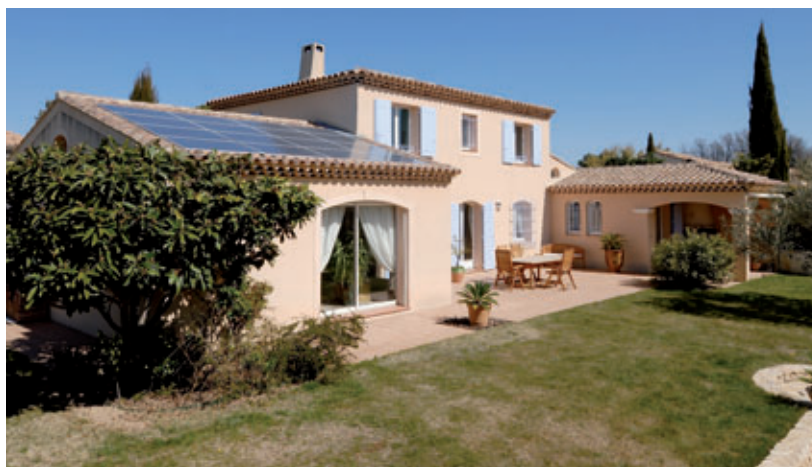
◀ Esempio di totale integrazione architettonica dell'impianto fotovoltaico sulla copertura a falde dell'edificio (foto Conergy).
