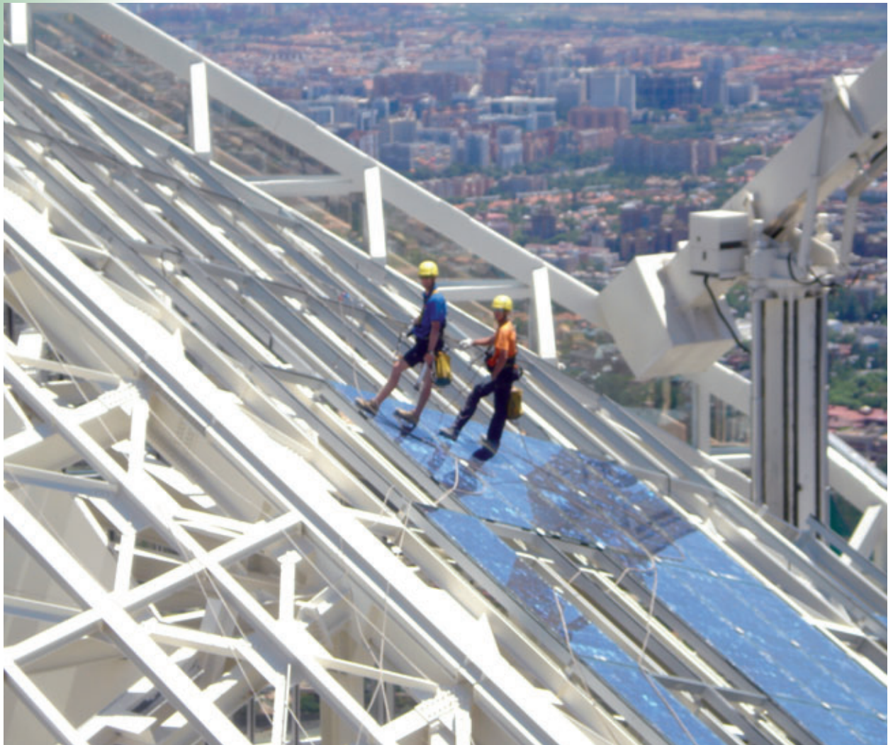
▶ Esecuzione della copertura della Torre de Cristal a Madrid (foto Martifer).
